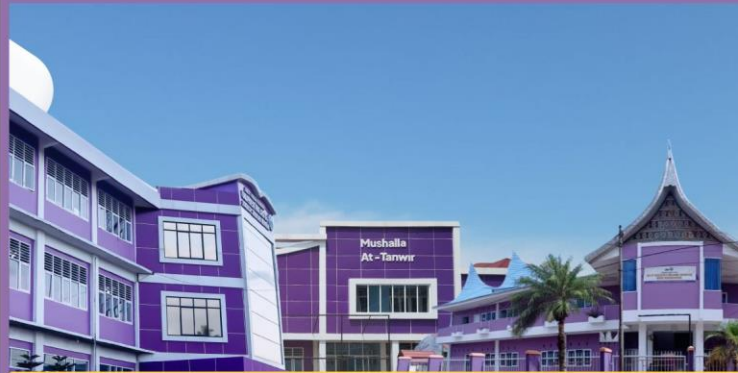
GEDUNG SEKOLAH & MUSHOLA
